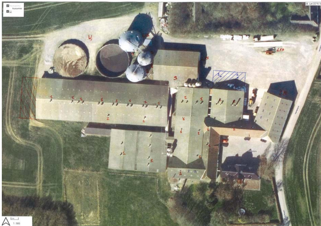
Figur 12. (1) Ventilationsafkast, (2) blæsere til korntøringsanlæg, (3) Møllarianlæg, (4) lastbil/traktor ved gyllebeholder, (5) Foderindblæsning.
